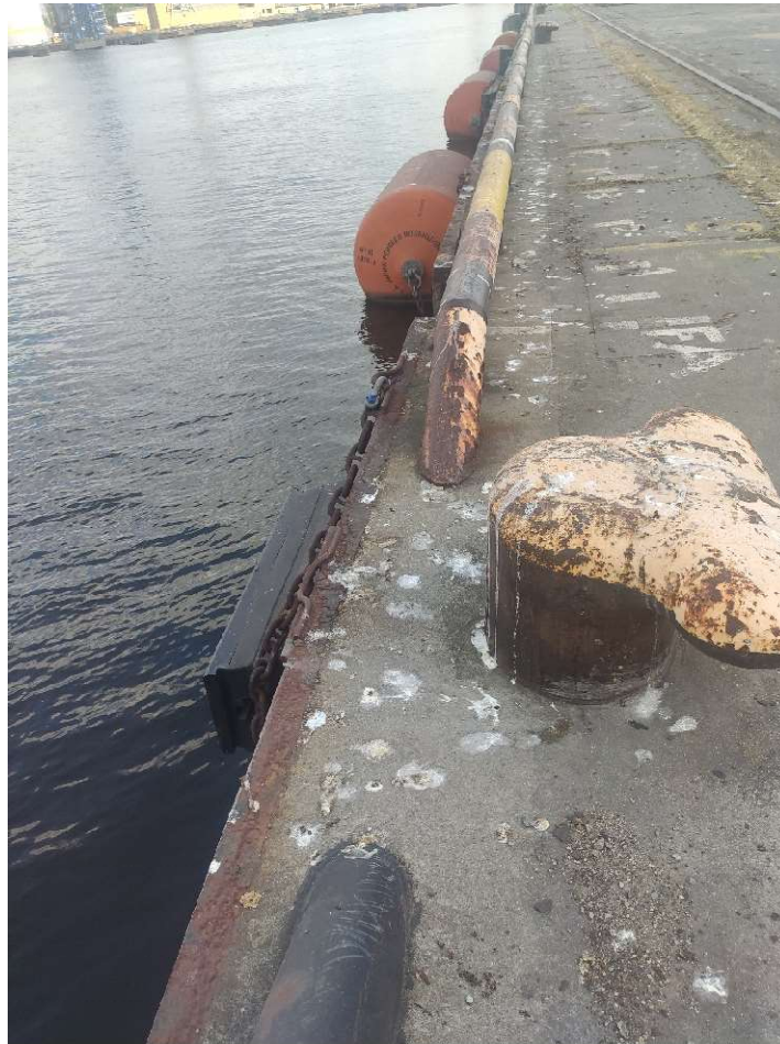
Att. 14 – Tērauda atvairbrusa (ar koroziju)
