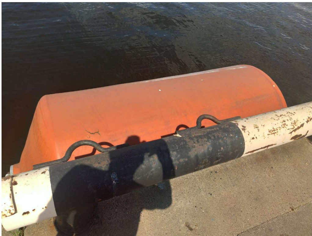
Att. 7 – Atvairierīce ar nelielu bojājumu aizsargkārtā
