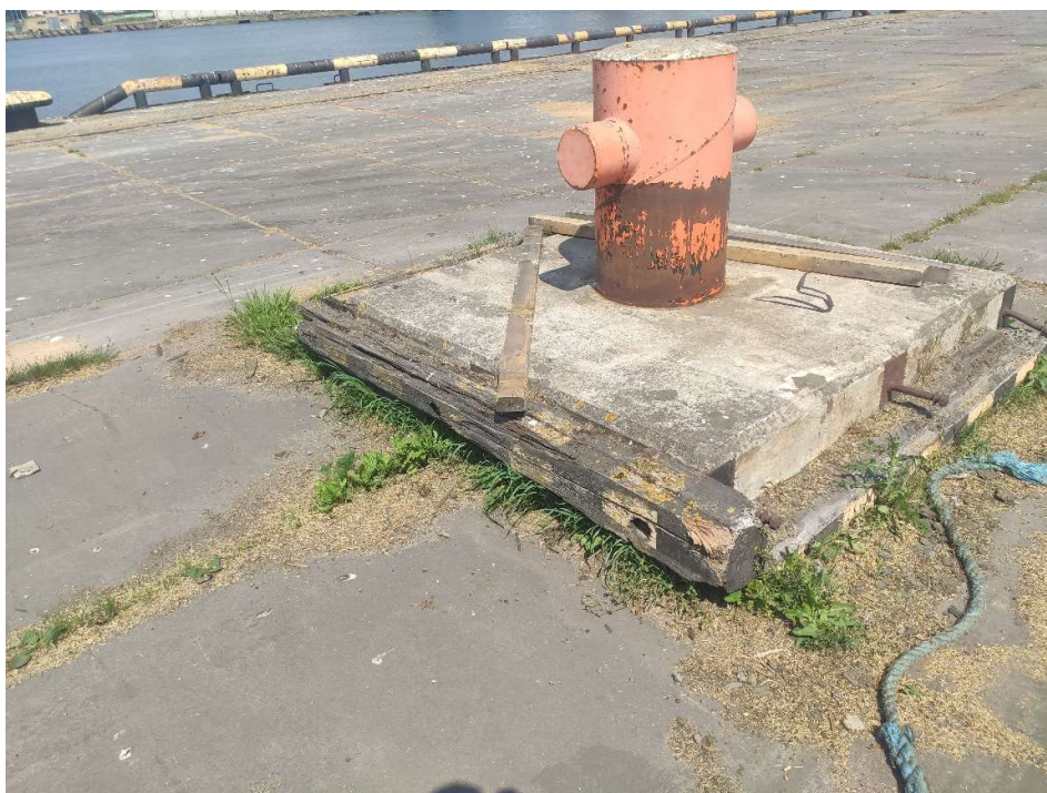
Att. 15 – Vētras poleru pamatnes aizargbrusas (sliktā tehniskā stāvoklī)
