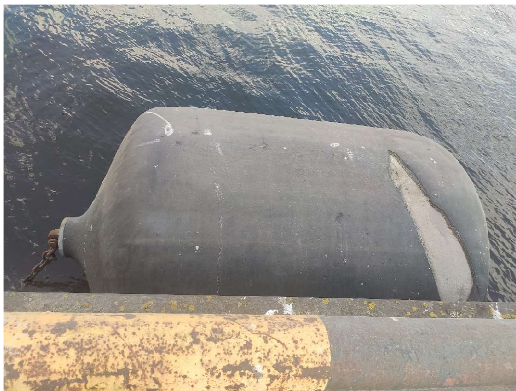
Att. 8 – Atvairierīce ar bojājumu aizsargkārtā
