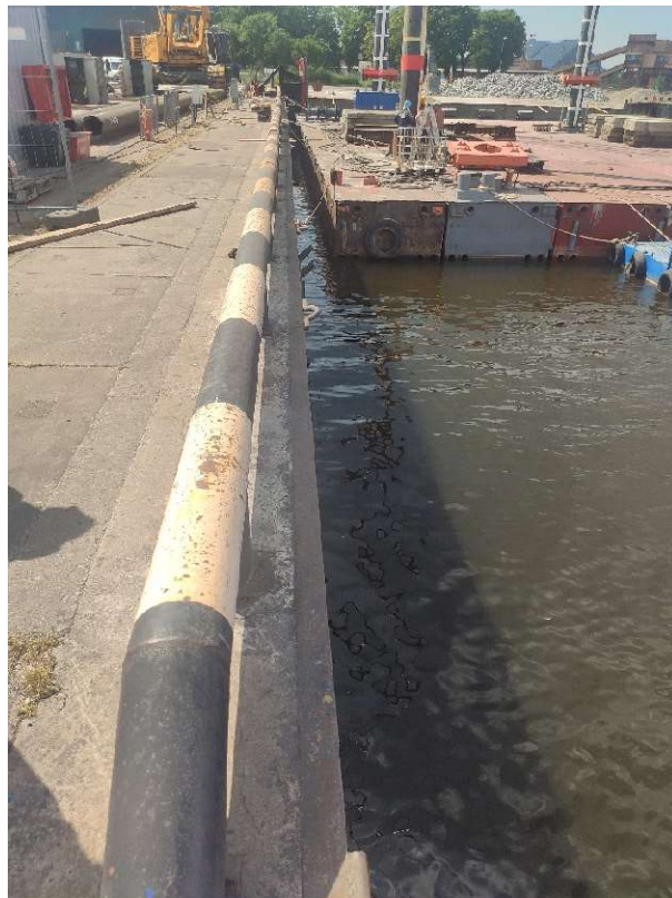
Att. 16 – Tērauda atvairbrusa (labā tehniskā stāvoklī)
